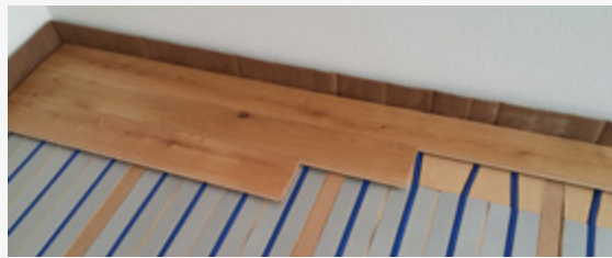
Verlegung von Massivholzdielen Einhaltung der Wandabstände von mindestens 15 mm!
