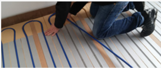
Randdämmungstreifen/Verlegeplatten/Heizungsrohre/Polsterhölzer gem. Systemhersteller verlegen.
